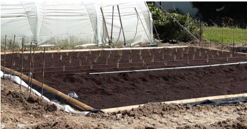
Photo 3 : Exemple de filtre planté
