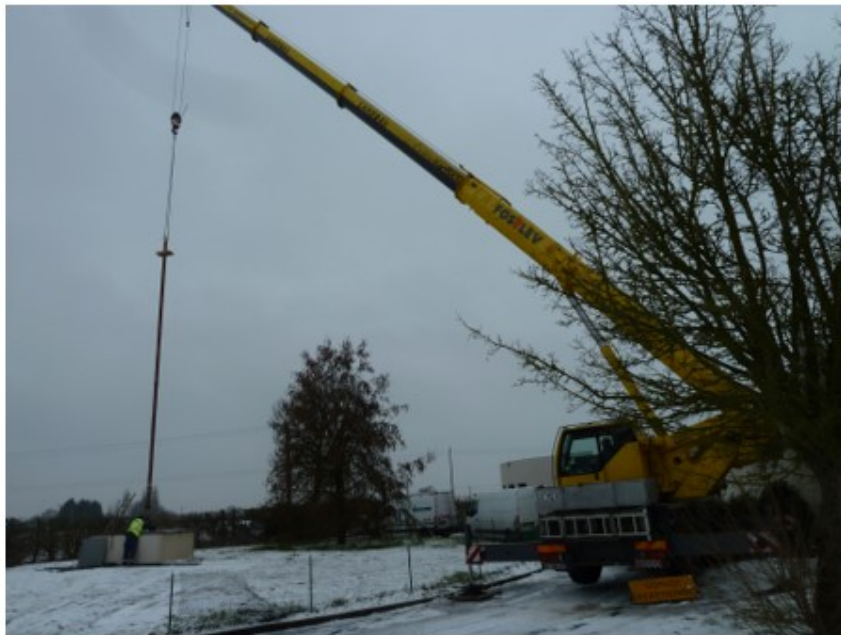
Renouvellement pompe de forage à NOYANT
