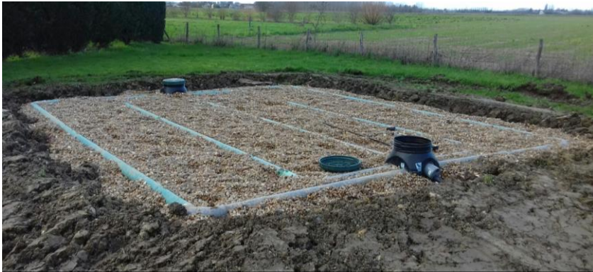
Photo 2 : Exemples de filière classiques (filtre à sable vertical non drainé et filtre compact à massif de zéolithe)
