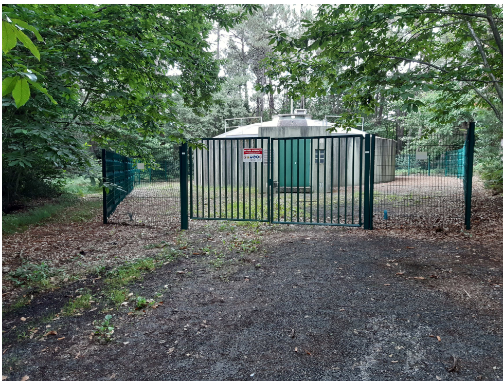
Réservoir semi-enterré de FONTAINE MILON
