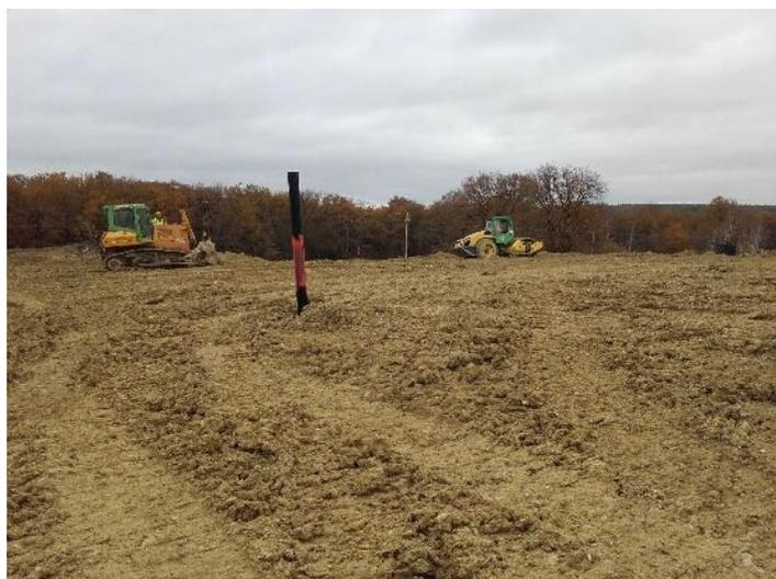
Figure 41 : Nouvelle torchère en 2018 et recouvrement de l'alvéole A19
