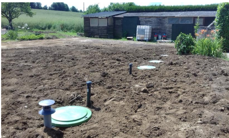
Photo 3 : Filtre compact avec pompe de relevage intégrée remblayé
