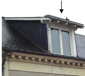
Les lucarnes doivent être conçues selon le type traditionnel local, avec une couverture à deux ou trois pentes. Les ouvertures des lucarnes doivent affecter la forme d'un rectangle plus haut que large (sauf pour les lucarnes de type « œil de boeuf ») de dimension inférieure aux fenêtres éclairant les pièces principales de la construction.
