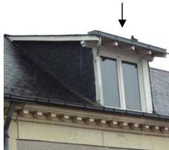
Les lucarnes doivent être conçues selon le type traditionnel local, avec une couverture à deux ou trois pentes. Les
